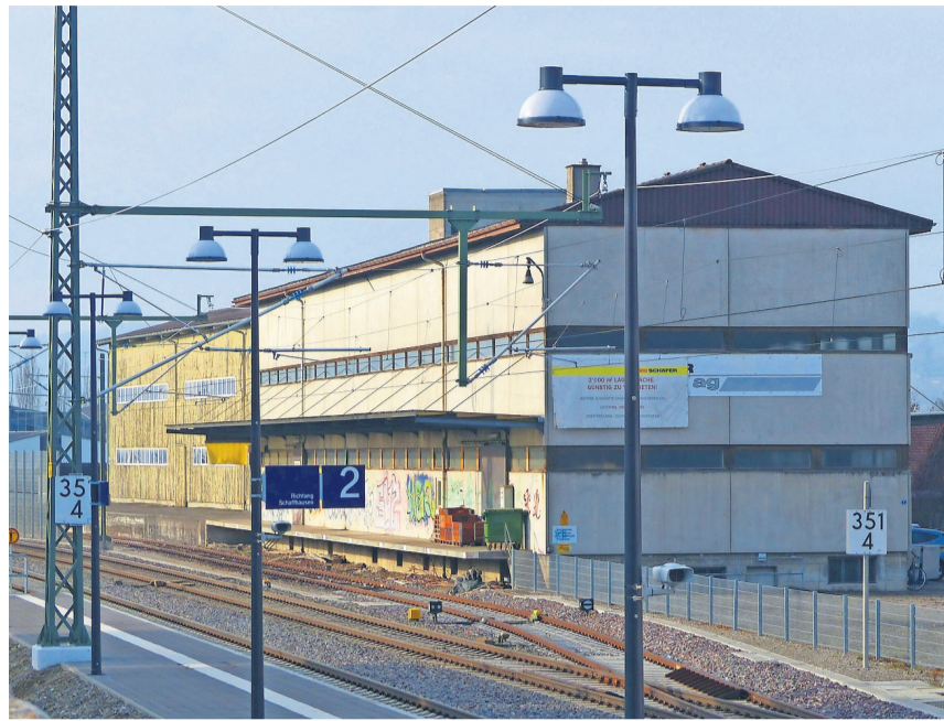
In diesem ehemaligen Lagergebäude der SSI Schäfer AG gleich neben dem Bahnhof Neunkirch soll das neue Ärztezentrum entstehen.
